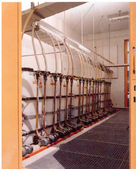
Entrepôt des adjuvants.
