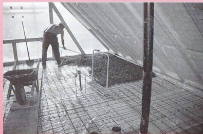
Bétonnage avec des moyens simples lors de la transformation de la maison du pasteur de Bassersdorf.
