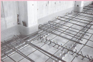
Détail d'un appui avant le bétonnage.
