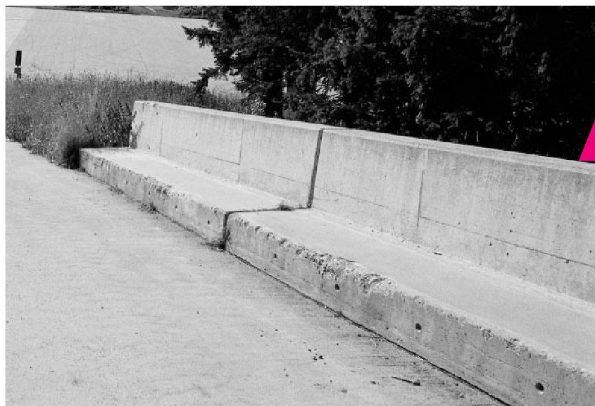
Dégâts dus aux sels de déverglaçage (éclatements) sur un parapet de pont.
