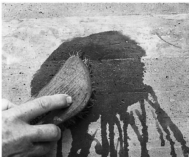
Fig. 11 Pour terminer, la pâte adsorbante est éliminée avec une brosse et de l'eau savonneuse.
