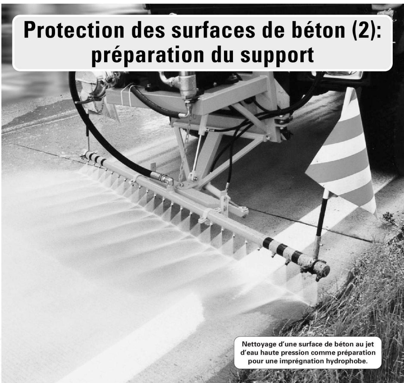
Nettoyage d'une surface de béton au jet d'eau haute pression comme préparation pour une imprégnation hydrophobe.
