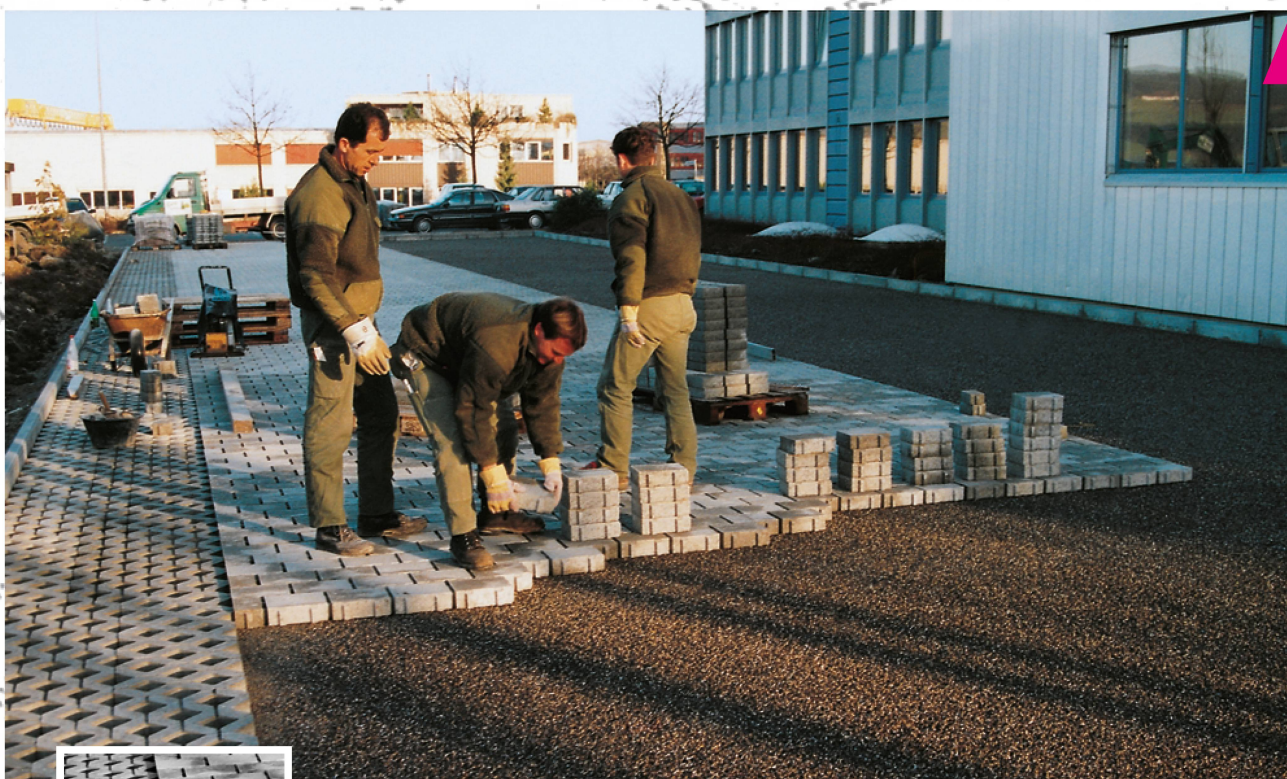
Pose manuelle de pavés en béton.
