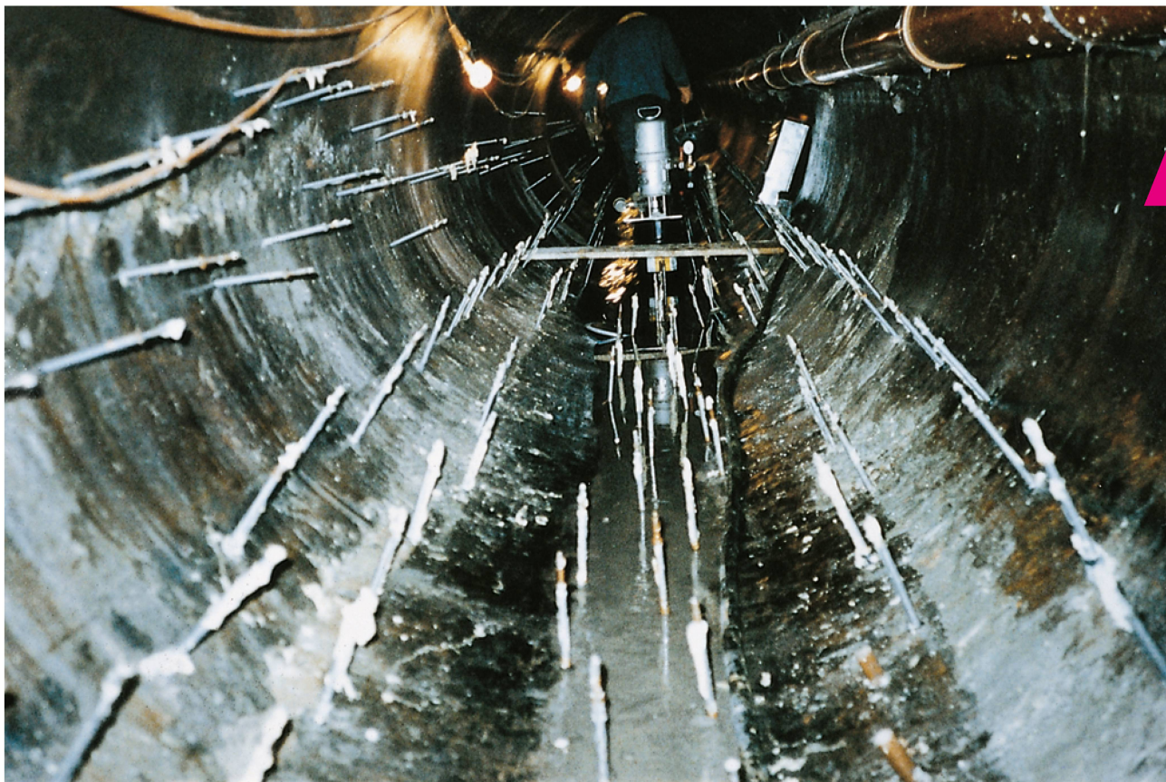
Manchette posée dans la zone du sol/radier d'une canalisation en béton.
