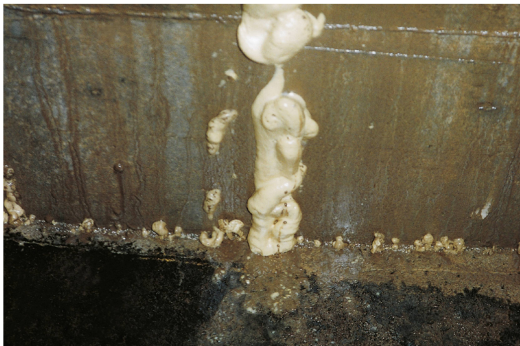
Arrêt de venue d'eau par injection PUR.
