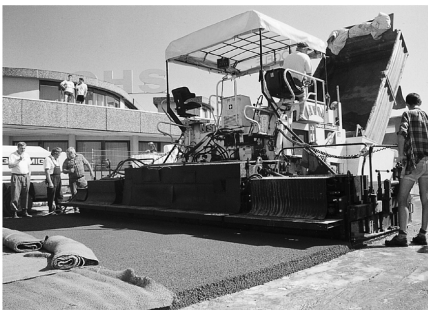
Mise en place de béton drainant.
