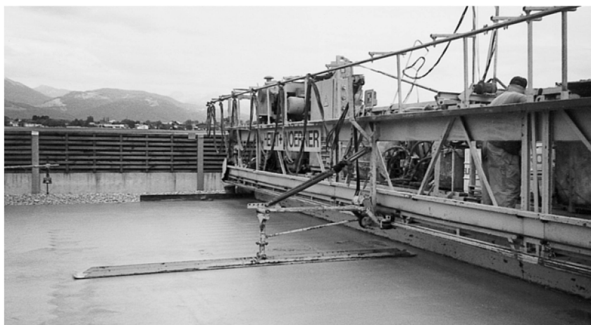
Talocheuse longitudinale en action.
