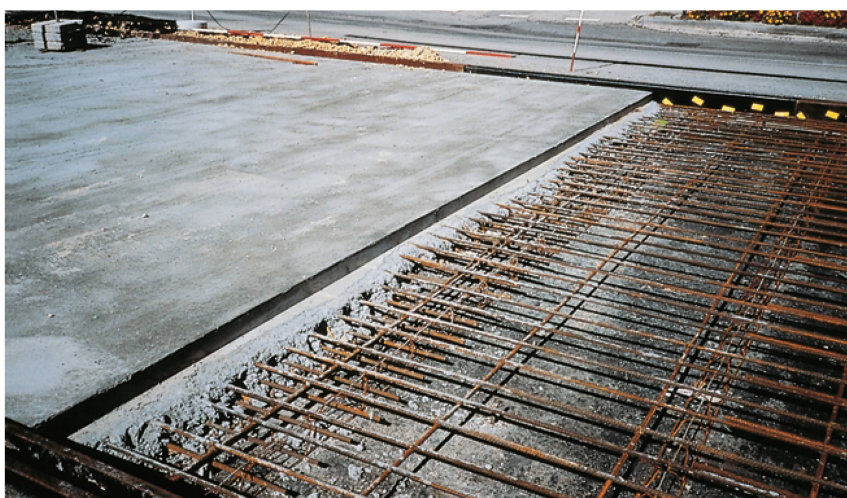
Joint de travail d'un revêtement en béton armé sans interruption (Le Locle, 1988).
