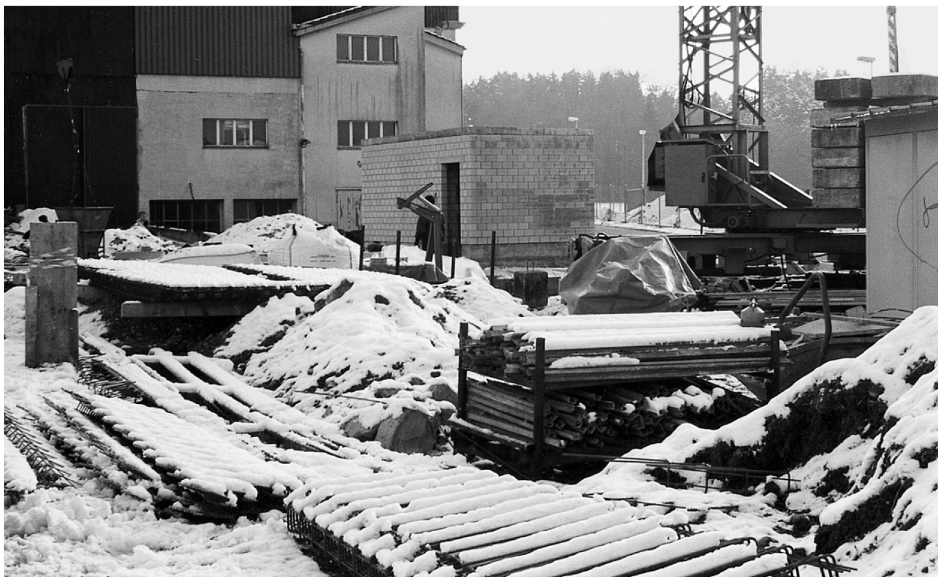
Bétonnage en hiver. Photos: K. Hermann, TFB
