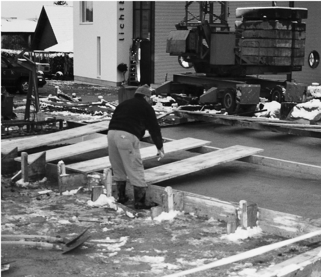
Préparation de l'isolation d'une dalle de fond fraîchement bétonnée.
