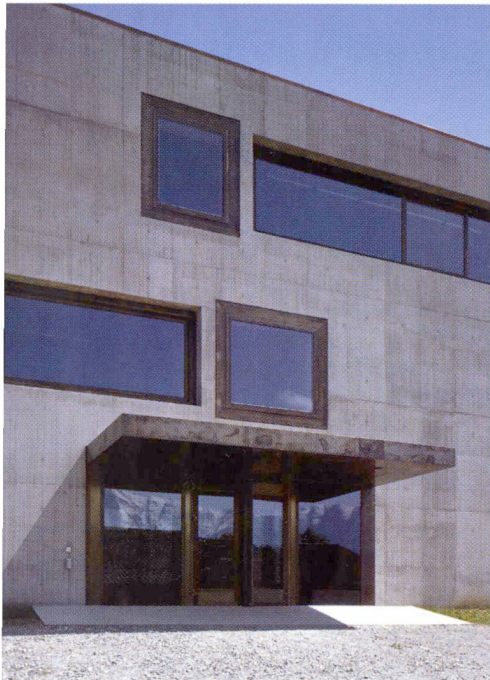
Façade d'entrée de l'école de Paspels.
