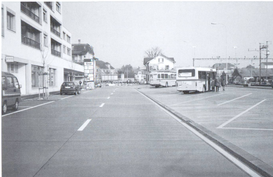
Laufenburg, place de la gare et route d'accès en béton.
