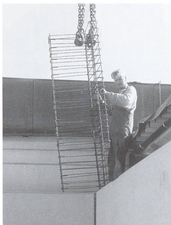
Fig. 9 Pose du panier d'armature aux angles des prémurs.
