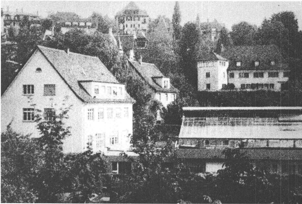
Abb. 3. Gebäude des Geobotanischen Institutes, Stiftung Rübel, an der Zürichbergstr. 38, nach dem Umbau 1966.
