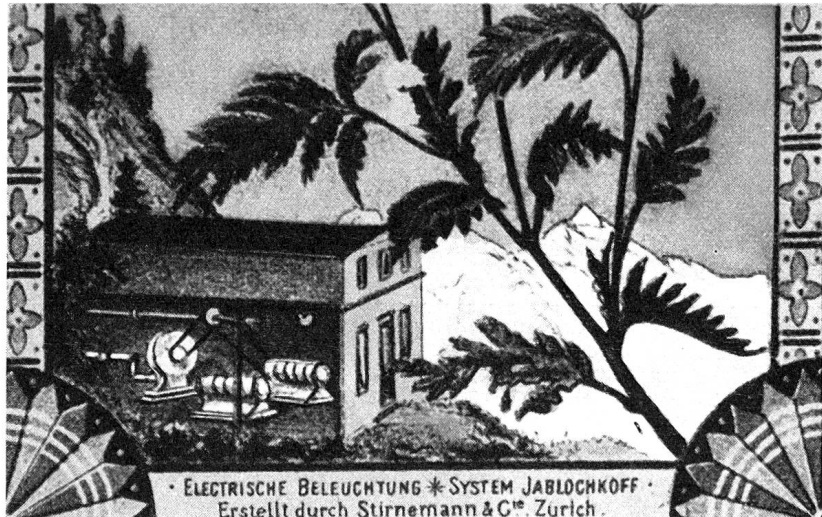
Das erste Elektrizitätswerk von St. Moritz und der Schweiz. Eröffnet 1878
