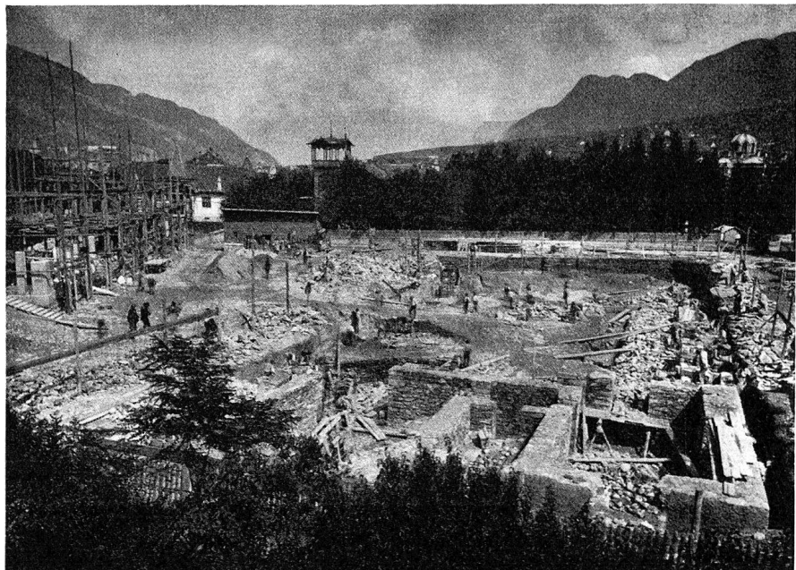
Diese Aufnahme zeigt die Fundierungsarbeiten des Jahres 1905 für die Hauptpost an der Grabenstraße. Auf dem gegenüberliegenden Areal steht ein hohes Haus, das damalige Chalet-Restaurant, das später der Villa Caflisch weichen mußte.
