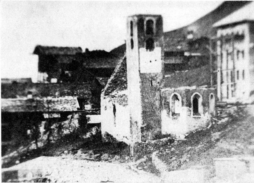
Abb. 2 Die ausgebrannte Dorfkirche, rechts das Sprecherhaus im Wieder- aufbau, links vorn das alt Pfrundhaus, das von den Pagigern gerettet werden konnte.
