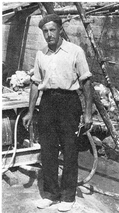
... als Sektions-Ingenieur beim Bau des Wasserkraftwerkes im Rincon de Bonete, Uruguay, 1938.
