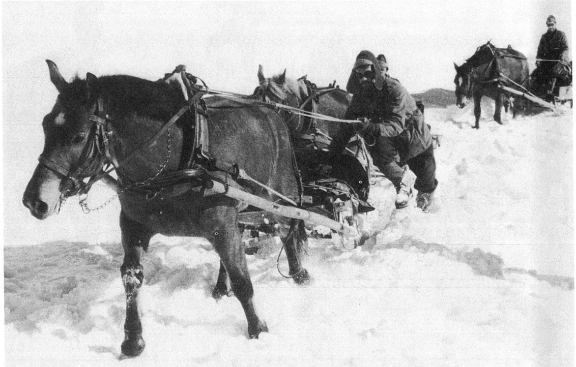
Der gebrochene und gefestigte Ruttnerpfad wird mit Schlitten trassiert, deren Kufen man quer mit einer Kette verbindet.
