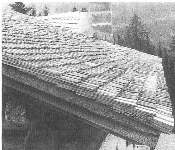
Ein fertig verlegtes Schindeldach.
