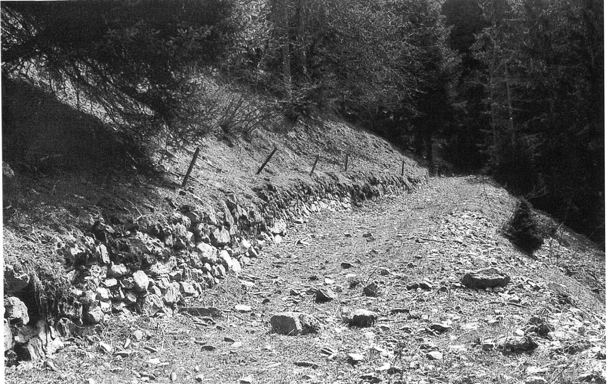
Foto 9: Das Strässchen von 1696 nördlich des Bergünnersteins. Der Weg ist heute noch problemlos bis kurz vor dem Bergünnerstein begehbar, wo er durch die Strasse des 19. Jahrhunderts überformt wird.
