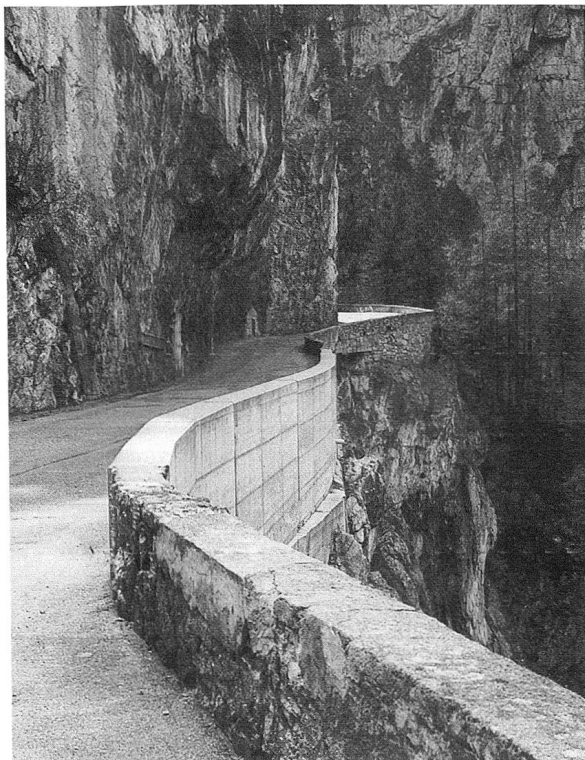
Foto 10: Die Passage durch den Bergünnerstein 1994. Die talseitigen Brüstungs- und Stützmauern waren in so schlechtem Zustand, dass sie inzwischen auf der ganzen Länge durch eine Betonmauer ersetzt werden mussten.
