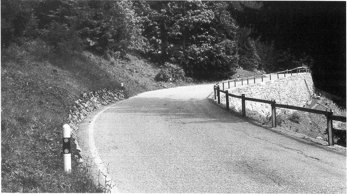
Foto 1: Die Albulastrasse zwischen Bellaluna und dem Bergünerstein vor der Sanierung anfangs der 90er Jahre: Talseitig dominieren Stützmauern aus gemörteltem Bruchstein und Bündnerzaun, während bergseitig mehrheitlich Trockenmauern Hang und Strasse trennen. Man beachte die dem Gelände angepasste Linienführung und den günstigen Massenausgleich (kleine Böschungen).
