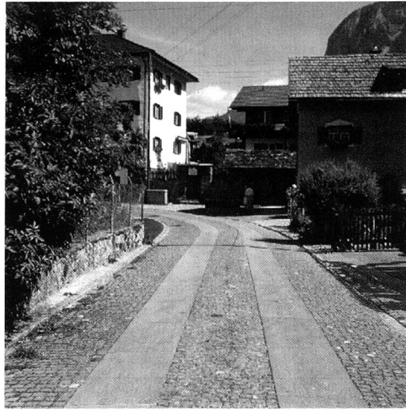
Abb. 7: Die vor wenigen Jahren mit grossem Aufwand neuerstellte Pflasterung der Italienischen Strasse in Andeer.
