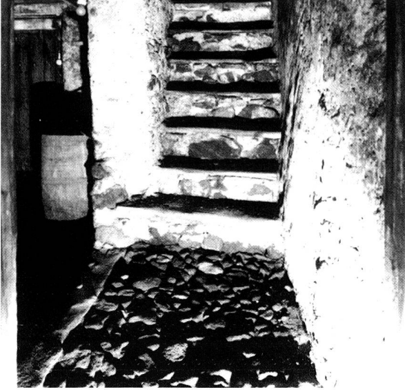
Abb. 24: Scuol Suot. Dualatsch. Podest der Kellertreppe. (Foto: Jachen Canal, Scuol).
