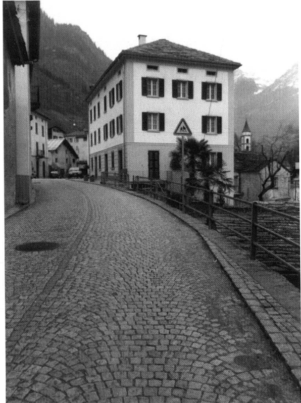
Abb. 30. Kantonsstrasse mit Bogenpflasterung aus Würfelsteinen. Foto: Alexander Troehler, Zürich.
