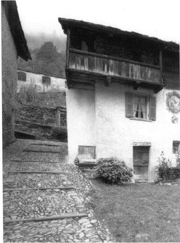
Abb. 29. Vertikalverbindung mit wild verlegter Schropfenpflasterung. Foto: DPG.
