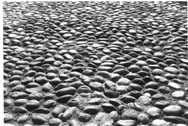
Abb. 32. Bollenpflasterung mit Flusssteinen Neuere Pflasterungsarbeiten. Foto: DPG.
