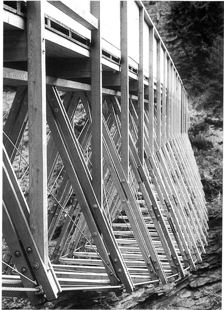
Ansicht des neuen Traversiner Stegs (Foto: J. C., August 1996).
