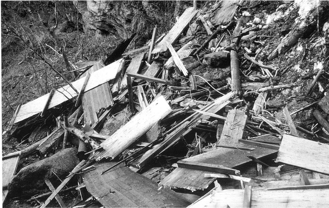
Zerstörter Traversiner Steg (Foto: J. C., 16. März 1999).
