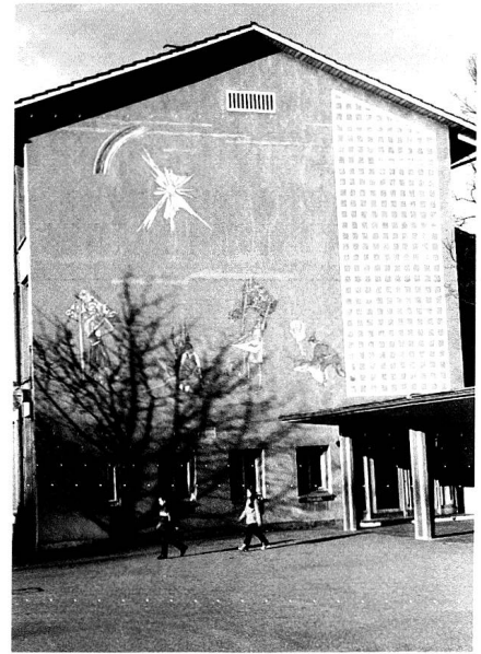
Schulhaus Daleu in Chur, Ostseite, mit Fassadenbild «Die Jahreszeiten» von Alois Carigiet, 1952, restauriert 1974 (vgl. Stadtarchiv F01.135a-e). (Foto S. Haas, 2002)
