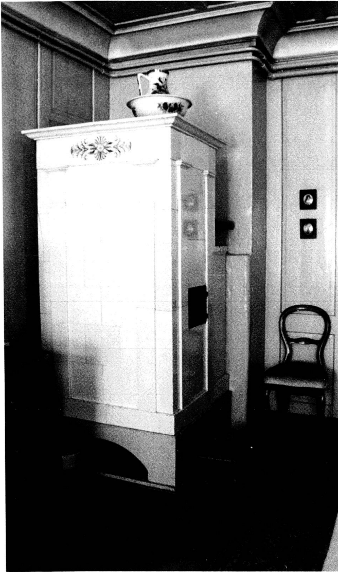
Der weisse Kachelofen im ersten Stock ist der einzige heute noch erhaltene Originalofen aus dem Jahr 1818. Um 1900 wurden alle anderen Öfen durch Kohleöfen ersetzt. (Foto M. B. 1996)
