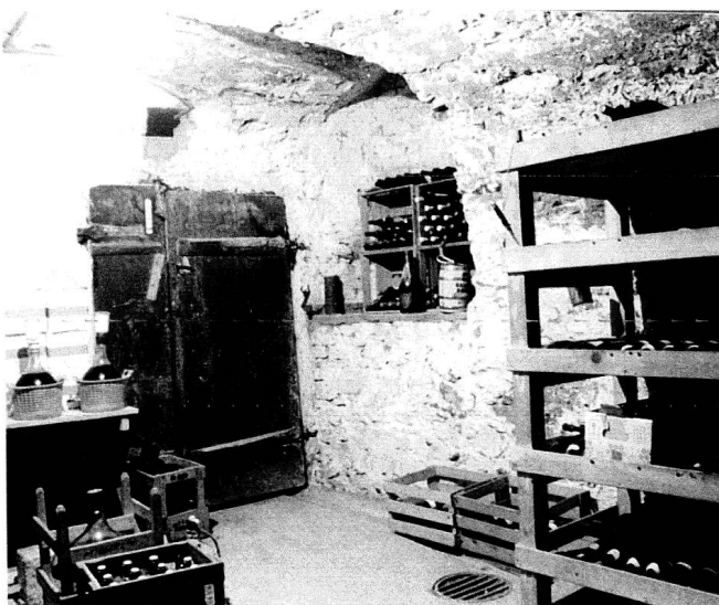
Der tonnengewölbte Keller der Bawierschen Weinschenke. Neben dem Keller stammt auch ein grosser Teil der Südfassade vom Vorgängerbau. (Foto M. B. 1996)
