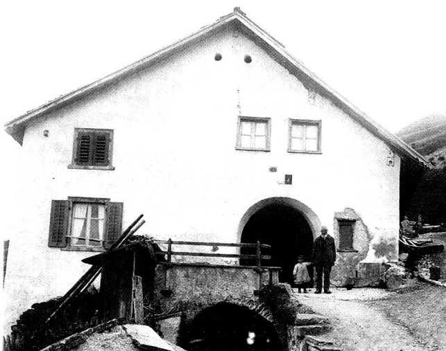
Chasa paterna in Ftan pitschen (R. C. cun bap Dumeng avant il solèr) um 1895. (Quelle: Archivgut «Robert Cantieni», Sign. XIII)
