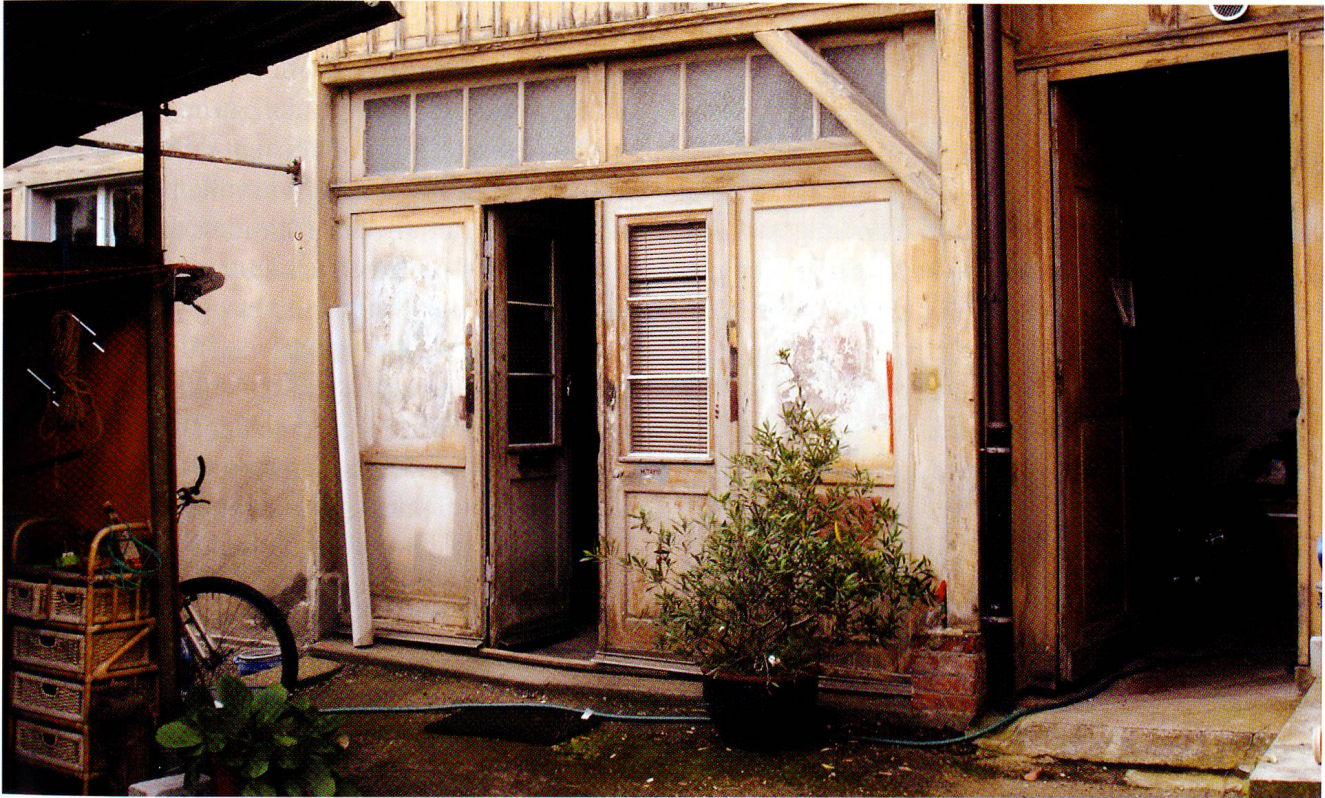
Eingangssituation Atelier. (Foto: Luciano Fasciati, 2005)
