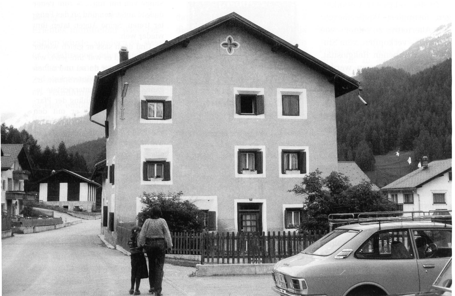
Pfarrhaus in Fuldera vor der 1983 erfolgten Renovation. (Quelle: Pravenda reformada, 7533 Fuldera)
