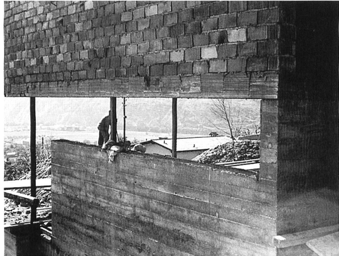
Das Haus Zinsli von der Südseite aus. Der gesamte Kubus des ersten Stocks wird süd- und westseitig von schlanken Säulen und ost- und nordseitig von der Hausmauer getragen. (Quelle: Pb. VZ)
