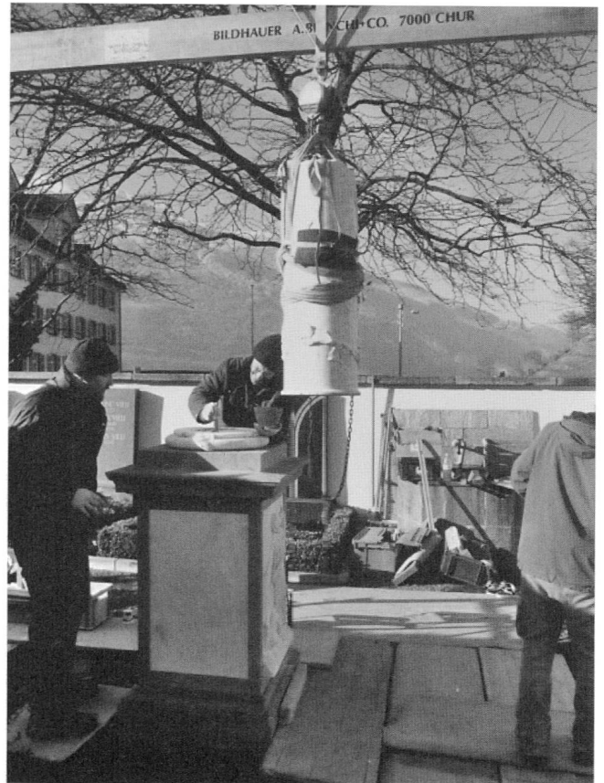
Die Säule wird angemörtelt und gesetzt.
