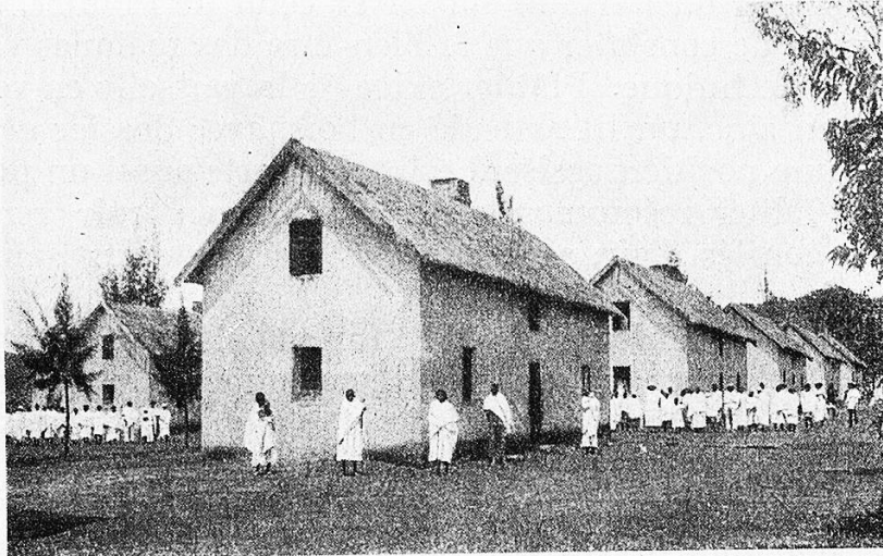
Wohnhaus für Leprakranke
