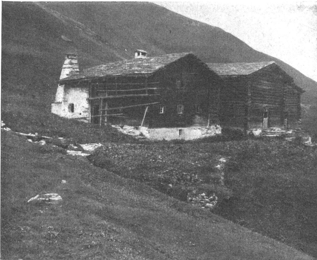
Das Gandahaus am alten Standort
