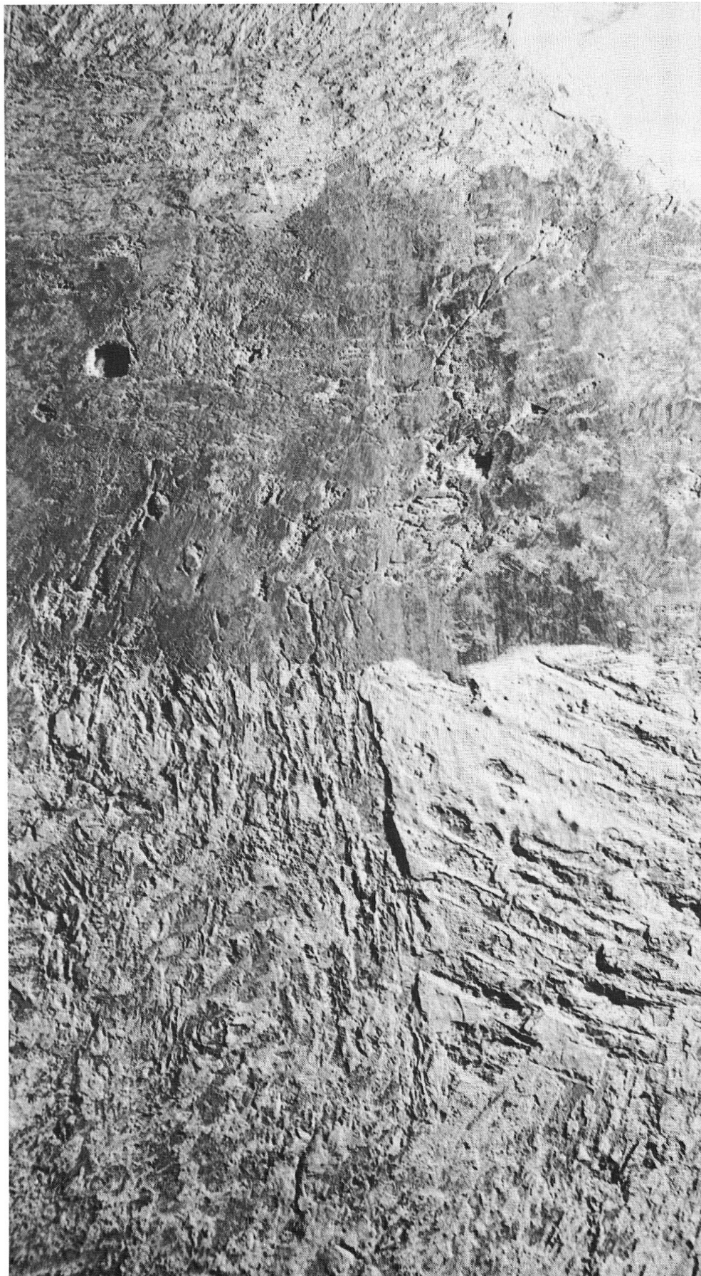
Abb. 12. Celerina, ref. Kirche San Gian, Wandmalerei um 1495: Hacklöcher und Kratzer bei der Freilegung 1901 entstanden. Die sehr harten, bis zu 70% verbliebenen Kalk- übertünchungen konnten bei der Restaurierung 1977–80 mit dem Wellenmotor reduziert und schliesslich mit dem Pulverstrahl- gerät restlos entfernt werden.
