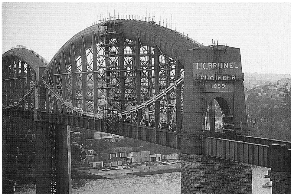
Isambard Kingdom Brunel (1806 – 1859): The Royal Albert Bridge über die Mündung des Tamar River bei Saltash (Plymouth), eröffnet 1859. Zwei Hauptöffnungen von je 136 m Spannweite. (Foto: Jürg Conzett)
