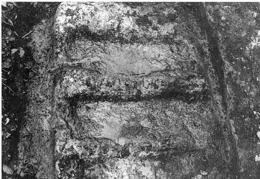
14 Treppenstufen zwischen den Rinnen (La Tanne). Die korrekte gegenseitige Positionierung ist nur durch gleichzeitige Ausmeisselung erklärbar. Die «Schönheit» der eingetieften Stufen und ihre Unzweckmässigkeit wegen gefrierendem gestautem Wasser drängen Fragen nach der Effizienz des Verkehrs auf.
