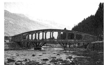
Im Auftrag des Bündner Heimatschutzes erstellte Bauuntersuchungen und Sanierungskonzepte bilden Grundlagen, um die Lawingalerie am Splügenpass und die Landquartbrücke Dalvazza zu erhalten. (Fotos: Jules Spinatsch, Archiv Tiefbauamt Graubünden)
