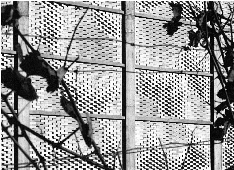
Fläsch, Weingut Gantenbein. Fassadendetail mit den mittels Roboter gemauerten Wandelementen aus Klinkersteinen (Foto: Ralph Feiner, Malans).
