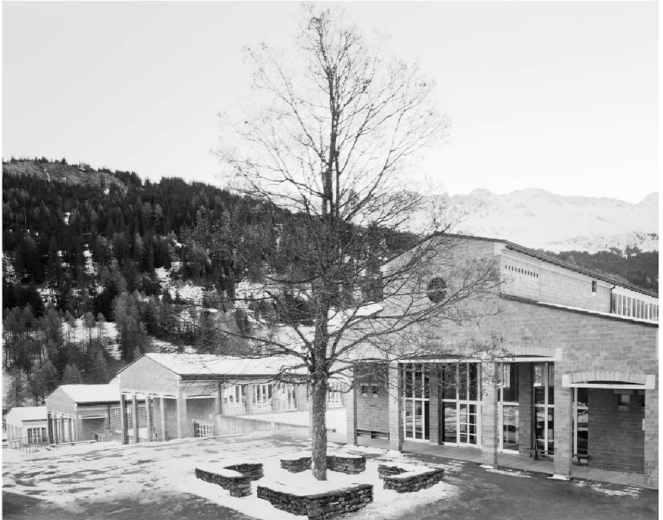
Erweiterung Kreisschule Churwalden, Peter Zumthor, 1979–1983.
