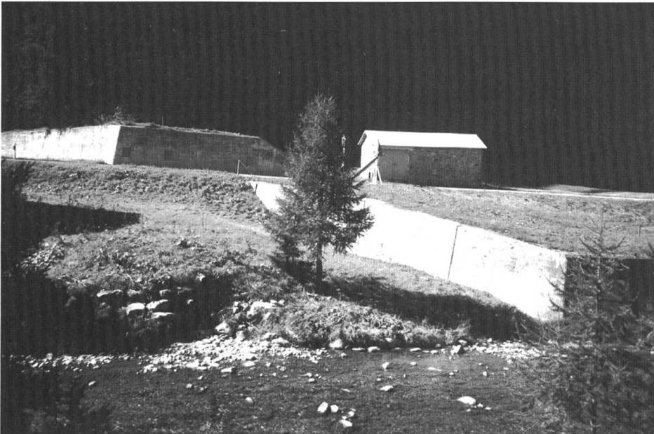
Das GPH Mulegns (T 04057) zeigt zwei massive Sperrmauern quer durch das Tal. In der schön gemauerten Hütte (mit Stahltor) waren die Einsteckelemente für die Strassenbarrikade eingelagert (Foto: ADAB-Inventar 1998).
