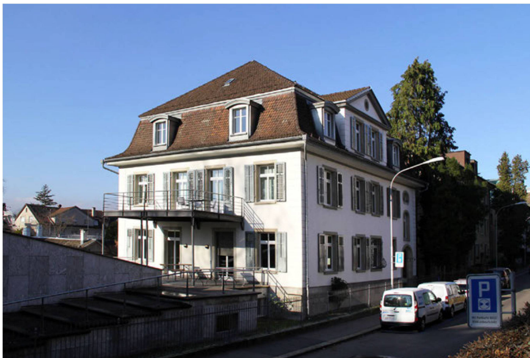
Abb. 11: Nordistik Zürich, Pestalozzistrasse 50 (Foto: Monika Gradalska)
