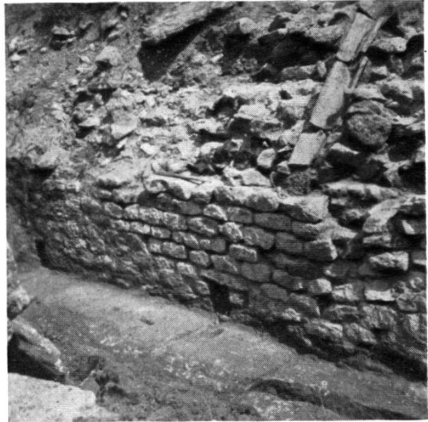
Fig. 2 - Drainages en tuiles romaines et barbacanes.
