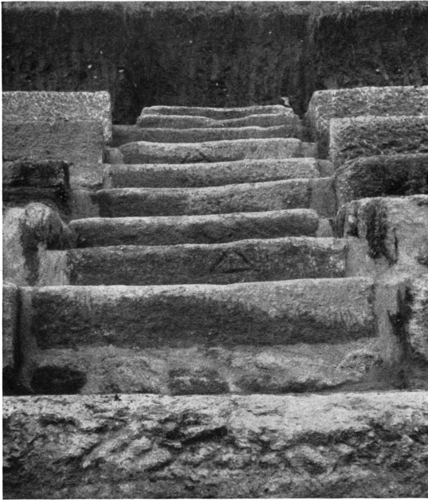
Fig. 38 - Secteur Nord. La rampe d'escaliers « in situ ».
