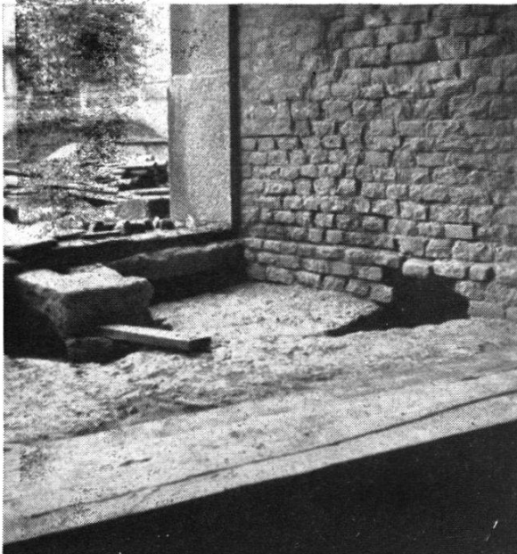
Fig. 33 - Seuil de l'entrée sud. Rencontre des 2 murs.
