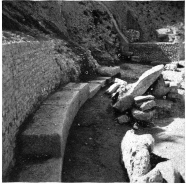
Fig. 14 - Le couloir. Assises du revêtement en gros appareil.
