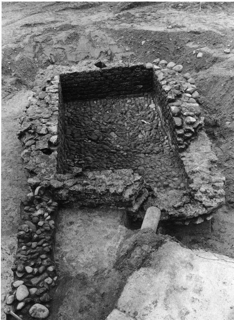
Fig. 21. Faubourg nord-est, zone 2. Vue de la cave depuis le nord. Dans les maçonneries sont visibles les trous d'encastrement des poutres verticales constituant l'ossature en bois de l'élévation des murs.
