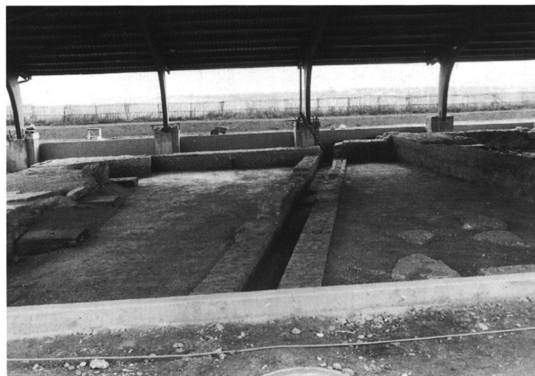
Fig. 20. Avenches / Insula 29, thermes de «Perruet». Le frigidarium restauré, vu du nord. A droite, on a noyé dans le remblai des éléments retrouvés du sol dallé, qui se trouvait à l'origine 1.2 m plus haut.
