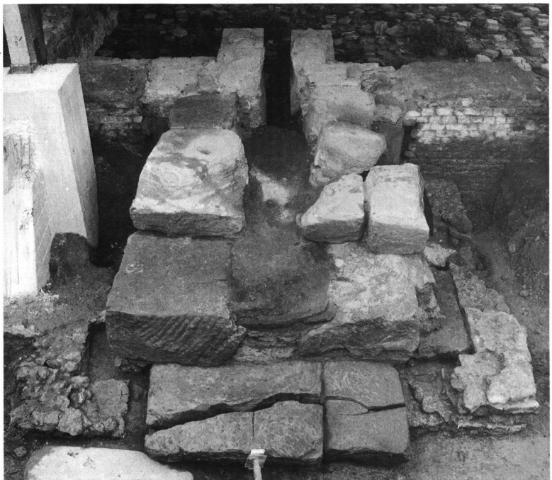
Fig. 15. Avenches / Insula 29, thermes de «Perruet». Les réfections du praefurnium nord du tepidarium . Vue du nord.
