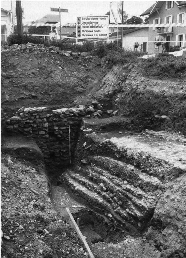
Fig. 23. Insulae 19/20, voirie, parement ouest du grand collecteur maçonné bordant l'insula 19 où apparaissent les négatifs des éléments verticaux et horizontaux du coffrage de construction. Au premier plan, mise en évidence de la stratification caractéristique de la rue (cardo 19/20).
