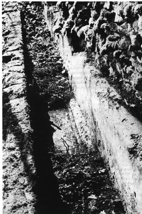
Fig. 10. Couzon-au-Mont-d'Or/Saute-de-Roche (Lyon/Mont d'Or): lo specus privo della copertura (da BURDY 1987, p. 8).
