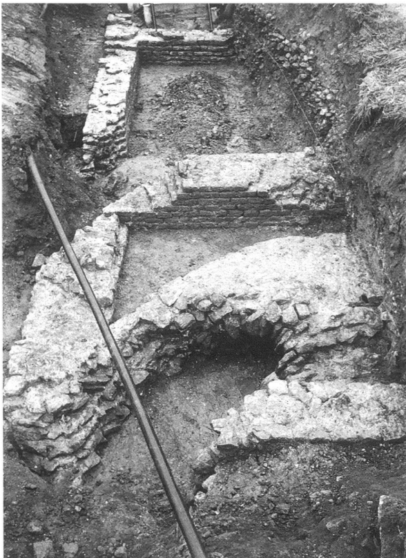
Fig. 18. Avenches/Chemin des Conches, insula 19. Vestiges de l'angle sud-est des thermes. Au premier plan, la voûte partiellement conservée de la canalisation coudeée (env. 72 ap. J.-C.). Vue du nord.
