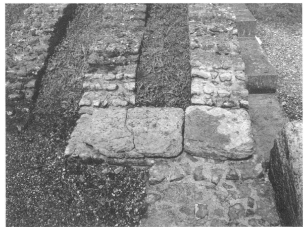
Fig. 6. Temple de la Grange des Dîmes. Murs d'échiffre de l'escalier avant et après nettoyage et colmatage des restaurations de la fin des années 1970 (photo MRA).
