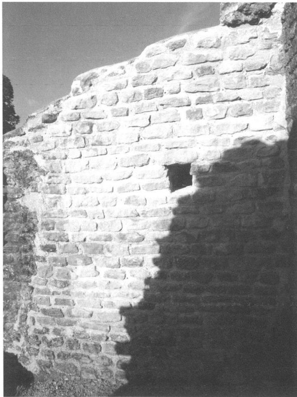
Fig. 5. Au Théâtre. Nouvel essai de restauration du parement du contrefort M 22 avec des moellons de grès de La Molière (photo MRA).
