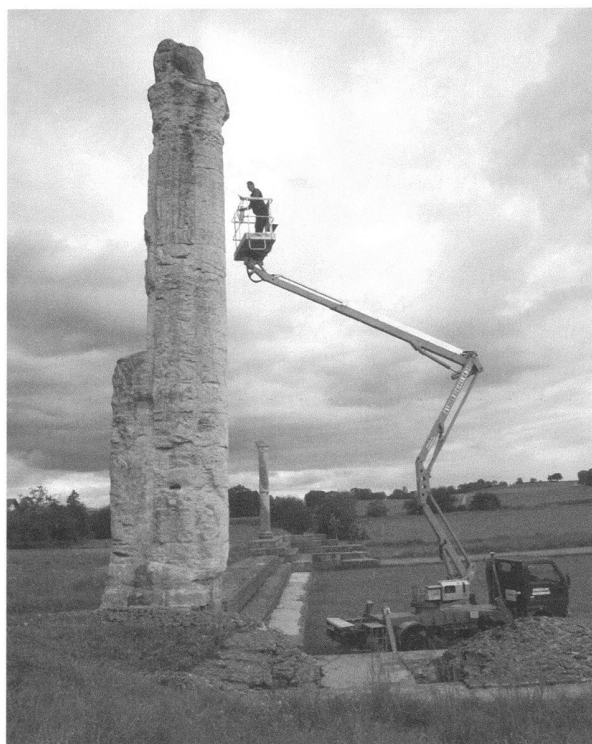
Fig. 2. Colonne du Cigognier. Nettoyage et examen de l'état de conservation grâce à une nacelle (photo MRA).
