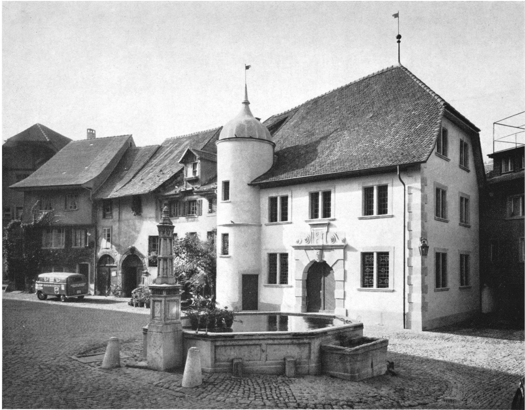
Brugg. — Zeughaus (Heimatmuseum) nach der Restauration
